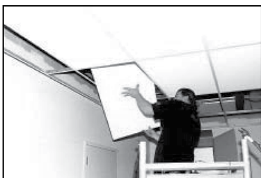
Figuur 6: Vulelementen in de draagstructuur leggen.
