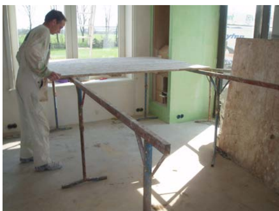
Figuur 4.8: Opbouw van een stukadoorsteiger
