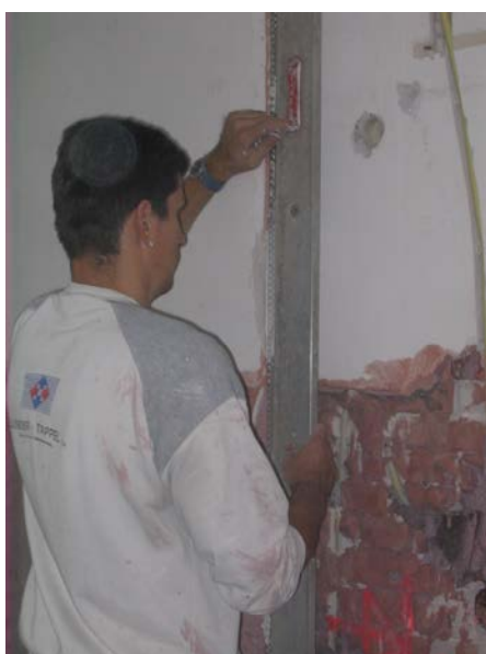
Figuur 5.29: Stellen van een hoekprofiel
