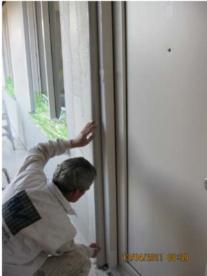
Figuur 6.27: Stellen van een hoekprofiel (-beschermer)
