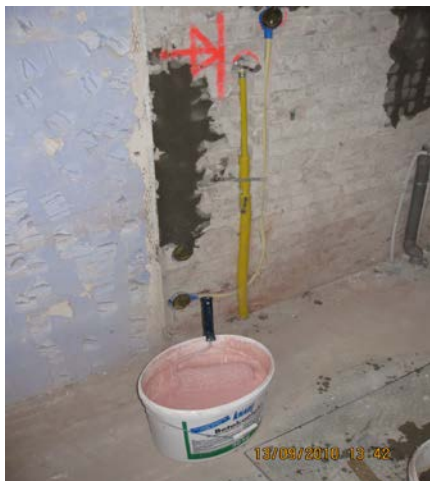
Grondeer en voorstrijkmiddelen hebben vaak een opvallende kleur die goed zichtbaar maakt dat de ondergrond is voorbereid.
