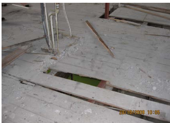
Figuur 4.7: Inspecteren of er veilig gewerkt kan worden is geen overbodige luxe!
