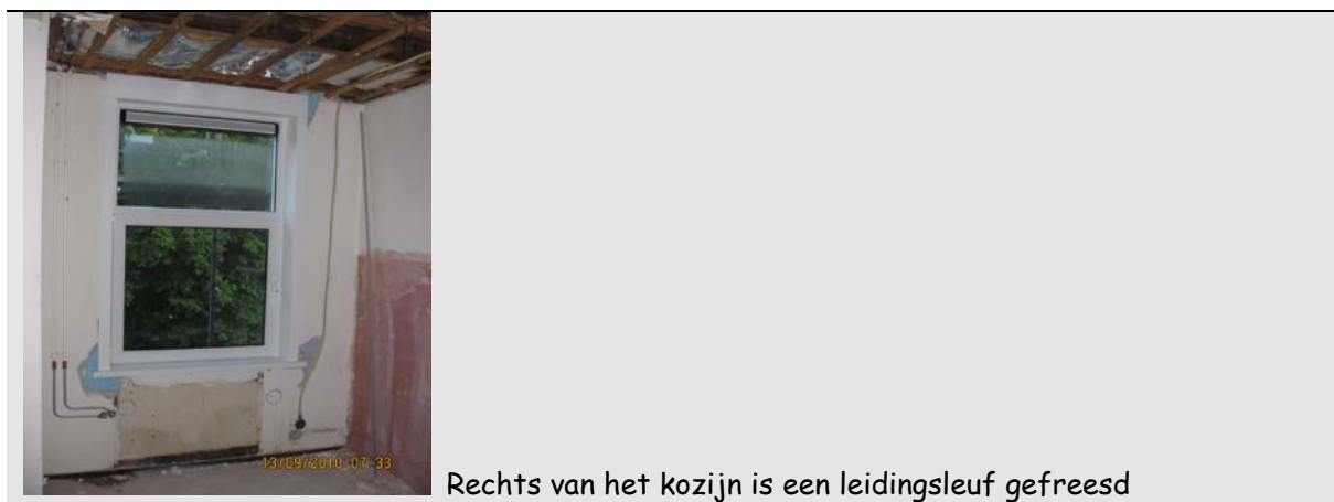
Figuur 5.35: Dichten van leidingsleuven (Bronnen: Meting en observatie, SAOB-tijdenarchief)
