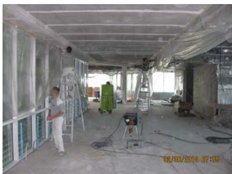
Figuur 5:14 (Foto links boven) Lijnvormig afplakken (van in dit geval een wand.)
