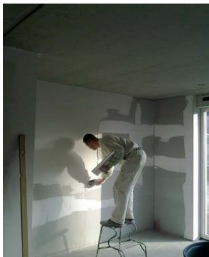
Figuur 5.45: Aanbrengen dunpleister op gelijmde wand van kalkzandsteen elementen
