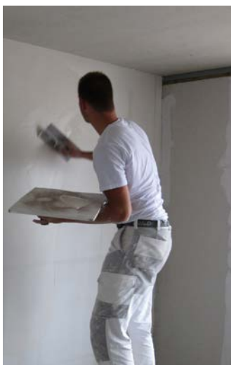
Figuur 2.5: Stukadoer bepleistert wand
