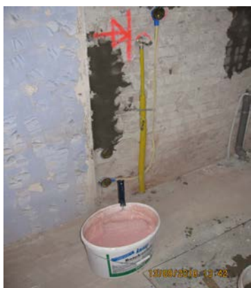
Grondeer en voorstrijkmiddelen hebben vaak een opvallende kleur die goed zichtbaar maakt dat de ondergrond is voorbereid.
