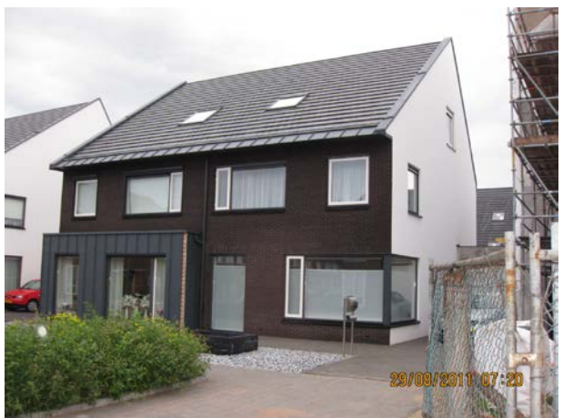
Figuur 6.44: Fragment van de kopgevel
