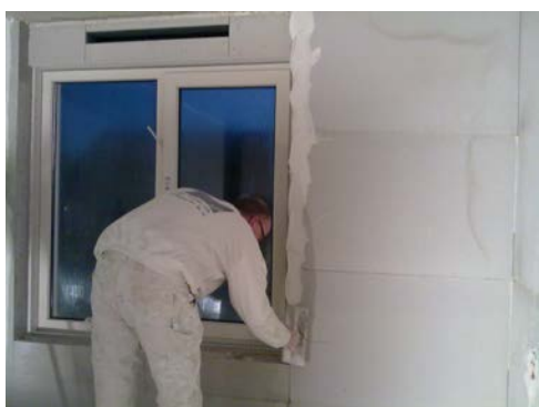
Figuur 5.33: Stukadoor brengt gips aan op de hoek van de negge
