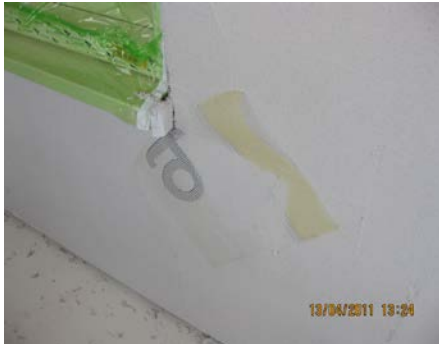
Figuur 6.29: Diagonaalsgewijze geplaatste weefselstrook
