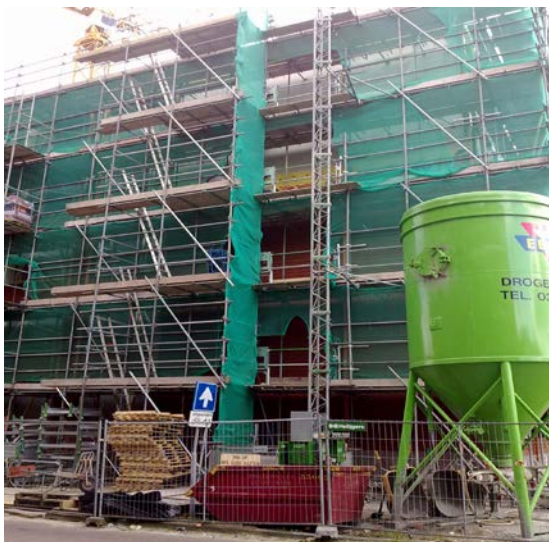
Figuur 7.2: Ladderportaal voor verticale verplaatsingen
